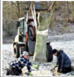
Frank Brinkmann und Vorarbeiter Alex Widuwild positionieren die Plastik auf dem Fundament Foto: Detlef Rohde
