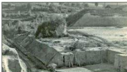
Tongrube Dresdener Straße
