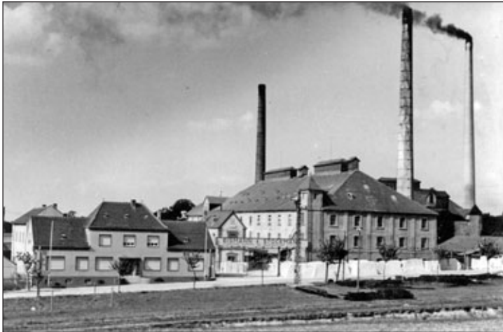
Schamottfabrik Eismann & Stockmann im Jahr 1939
