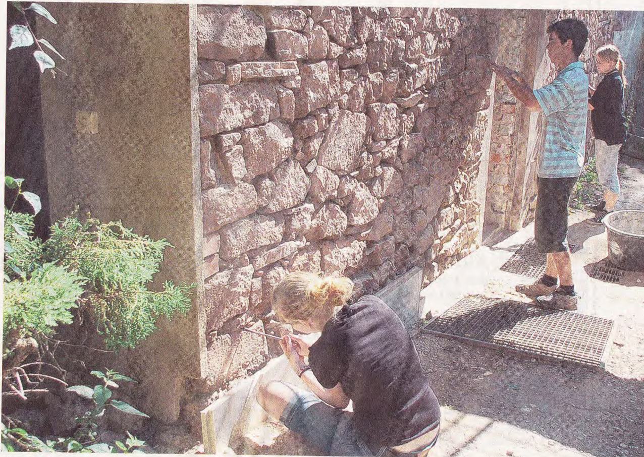
Abgeklopft: Mauerwerk sowohl außen als auch im Inneren der Gebäude des Kulturvereins Schaddelmühle befreiten jugendliche von losem Putz.
